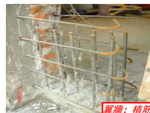
翼牆：植筋鑽孔
