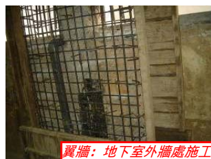
翼牆：單側鋼筋直通樓版穿孔
