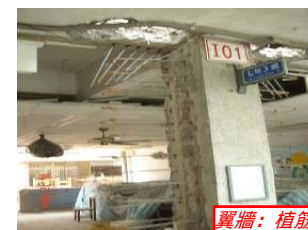
翼牆：植筋清孔
