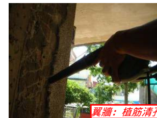
翼牆：植筋鑽孔
